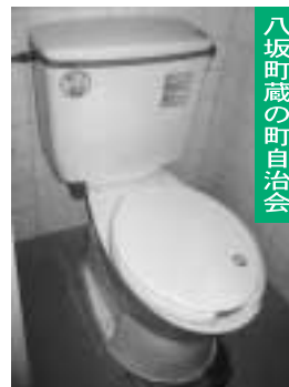
▲長年使用してきた集会所トイレを、高齢者サロン等の使用時にもやさしい洋式水洗化されました。
